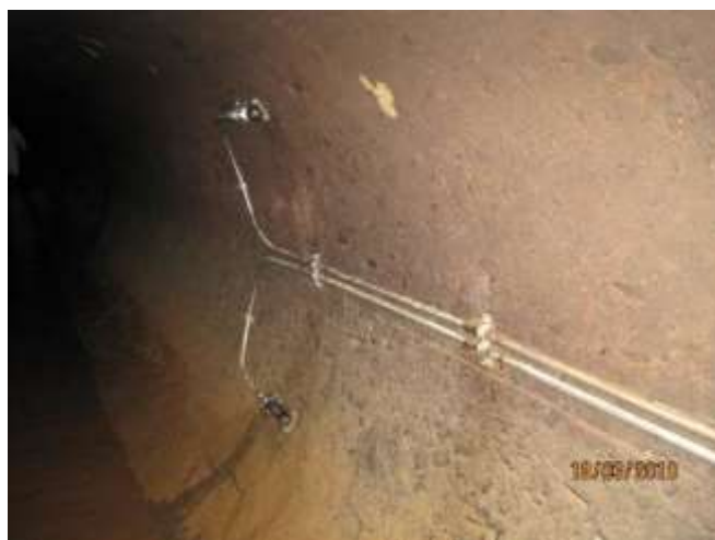
Fotos 16, 17 e 18 – Interior do túnel, comporta da tomada de água e sondas do caudalímetro.
