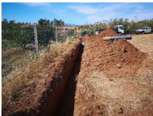
Fotos 1 e 2 – Colocação de tubagem de PVC.
