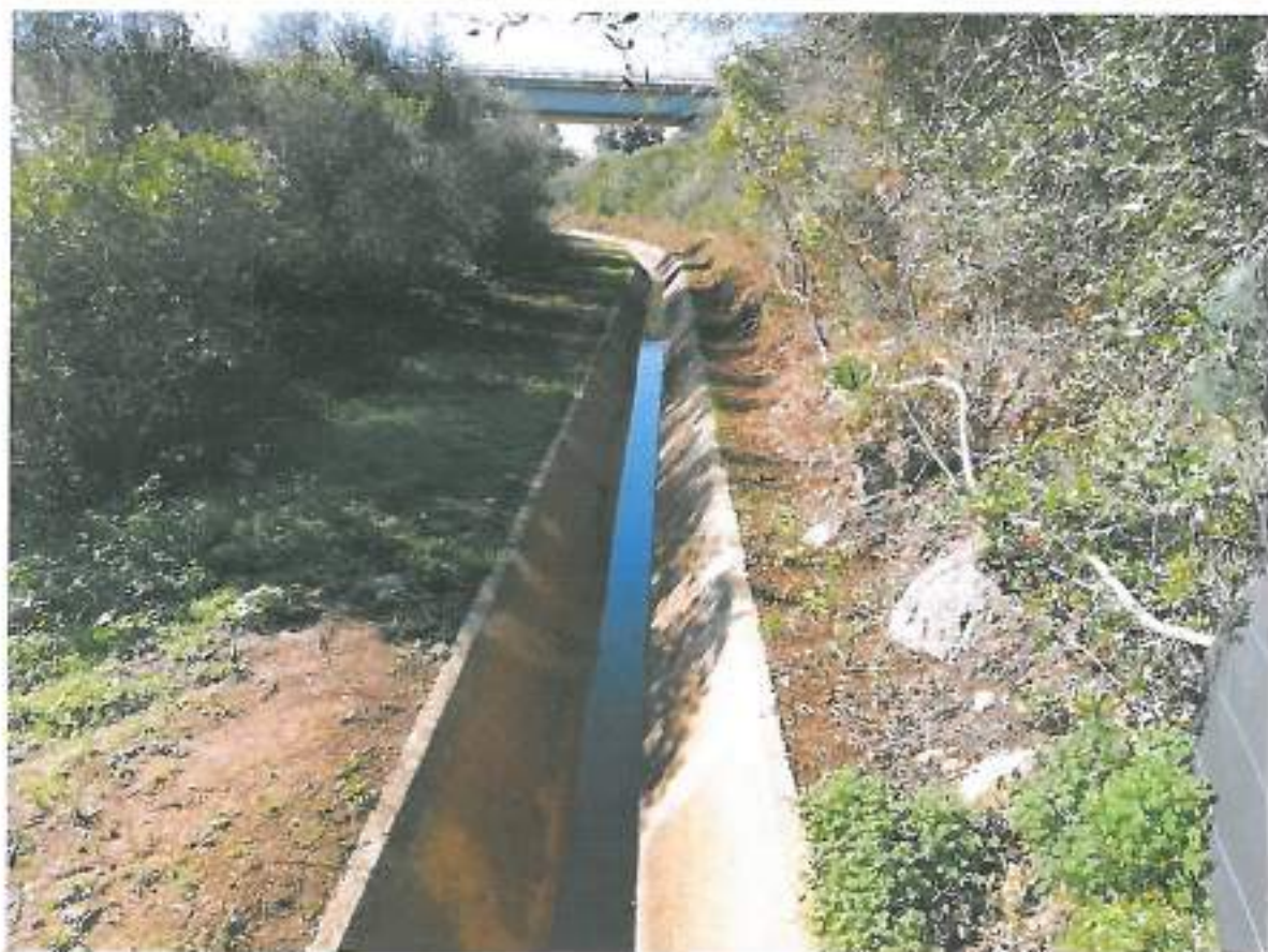
Fotos 12 e 13 – Distribuidor da Torre – Antes e após desmatamento.
