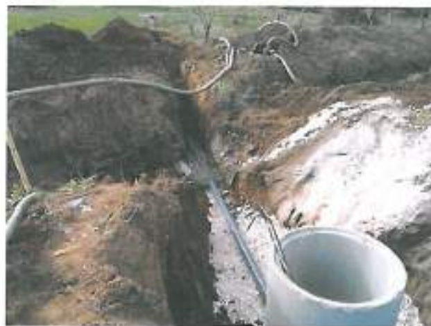
Fotos 1 e 2 – Colocação de tubagem de PVC.
