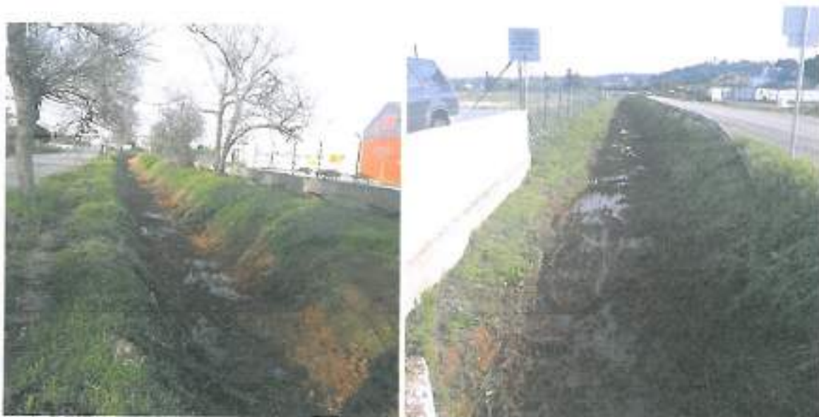
Fotos 17 e 18 – Vala de Enxugo após limpeza.
