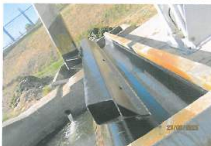
Fotos 21, 22, 23 e 24 –Limpa-grelhas da Estação Elevatória, antes e após a intervenção.
